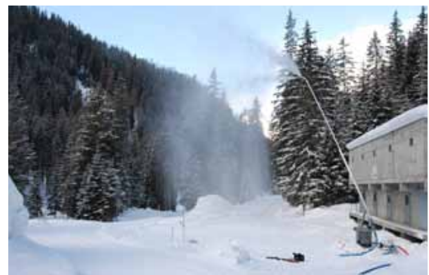
Mit dem Beschneigungssystem NESSy können Skipisten auch bei höheren Temperaturen energieeffizient beschneit werden.
